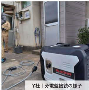
Y社 | 分電盤接続の様子
