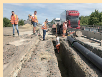
ドイツにおける施工実績写真
